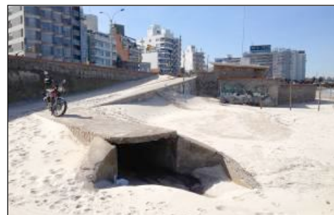
■ Rampa y salida de aguas pluviales en Playa Brava.
