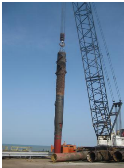
■ Extracción e incado de pilotes.
