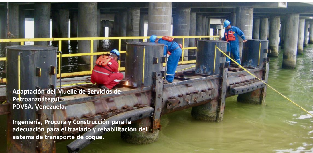
Adecuación integral de las instalaciones del TAECJAA PDVSA. Venezuela. Análisis, evaluación, selección e instalación de defensas y reacondicionamiento del sistema de asistencia de atraque de la Isla Norte.
