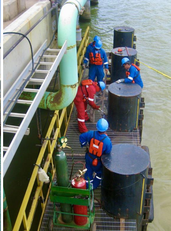
Adecuación integral de las instalaciones del TAECJAA PDVSA. Venezuela. Análisis, evaluación, selección e instalación de defensas y reacondicionamiento del sistema de asistencia de atraque de la Isla Norte.
